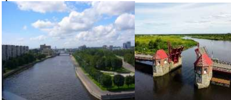
Рис. 2. Реконструкция набережных рек Преголя и Дейма
